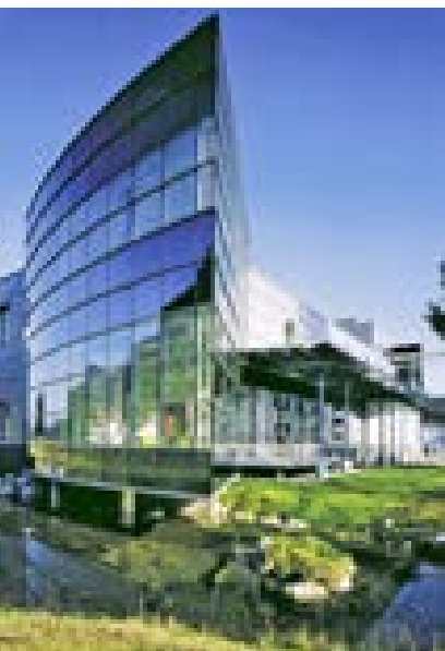
Werk Schafftenau mit Sandostatin-Anlage
